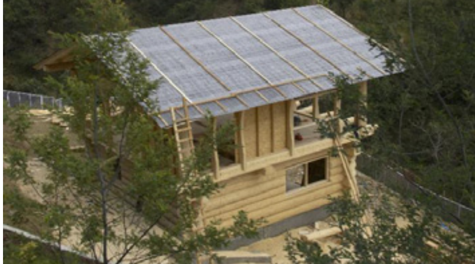
Baustelle auf 1.700 Metern Höhe
